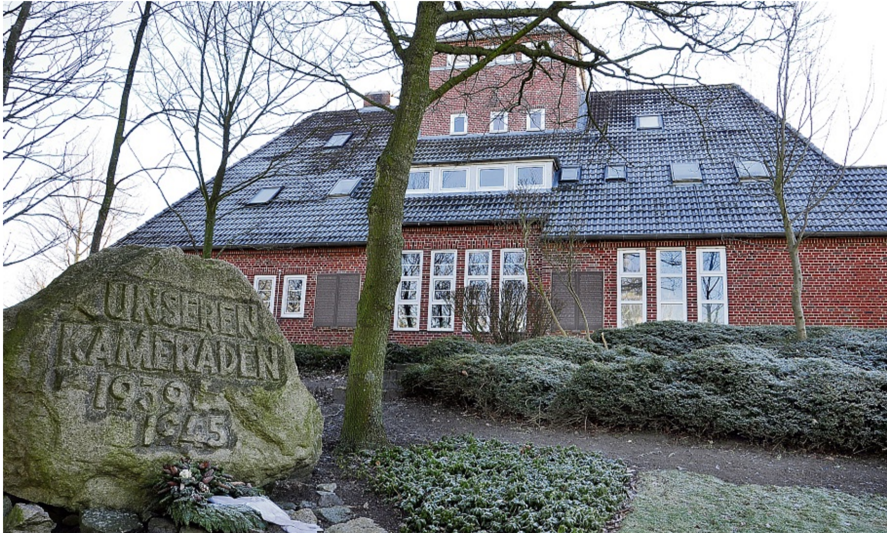
Die Neulandhalle: Erhabene Lage, „Hoheitsabzeichen“ und Rundblickmöglichkeit im Dachaufsatz sind deutlich erkennbar.
