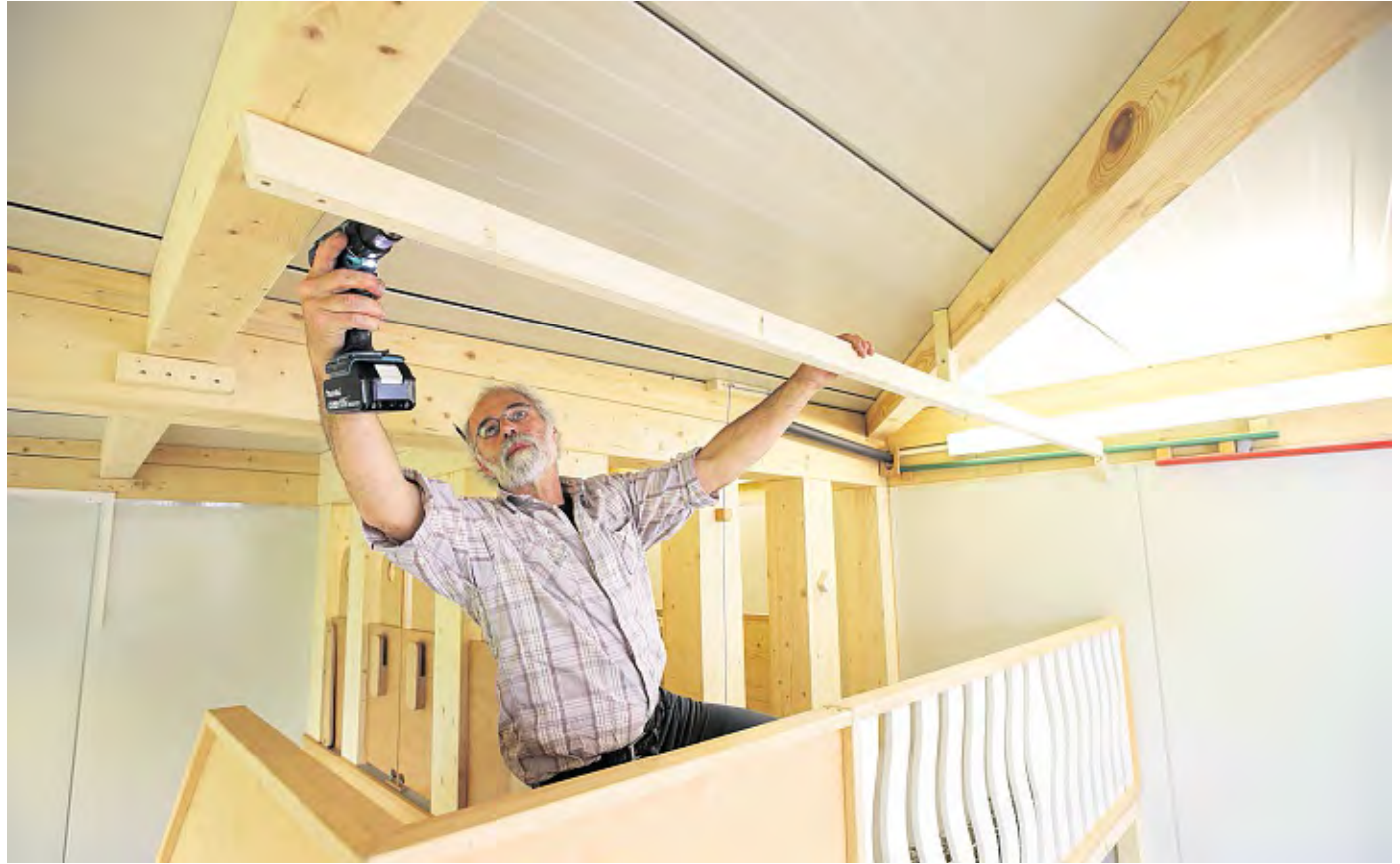
Letzte Handgriffe auf der „Mattisborg“: Tischler Thomas Wick installiert den Fallschutz mit Netz im Eltern-Kind-Arbeitsraum. M. STAUDT
