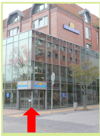
„ Mobilitätszentrale “ at Holmpassage, entry ZOB
