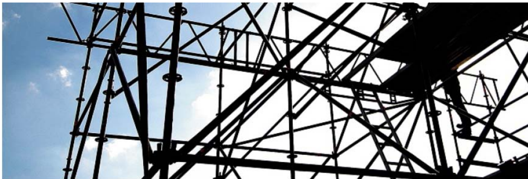
Wacklige Angelegenheit: Bei den Gerüstbauern wird das Problem unterschiedlicher Berufsabschlüsse besonders deutlich.
