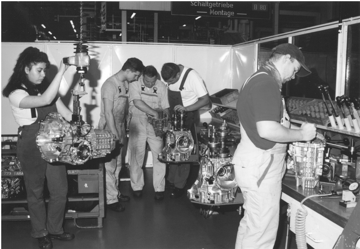
Abb 23: Auszubildende lernen und arbeiten im Qualifizierungsstützpunkt. Der Ausbildungsbeauftragte erläutert die Aufnahme des Wellenlagers.
