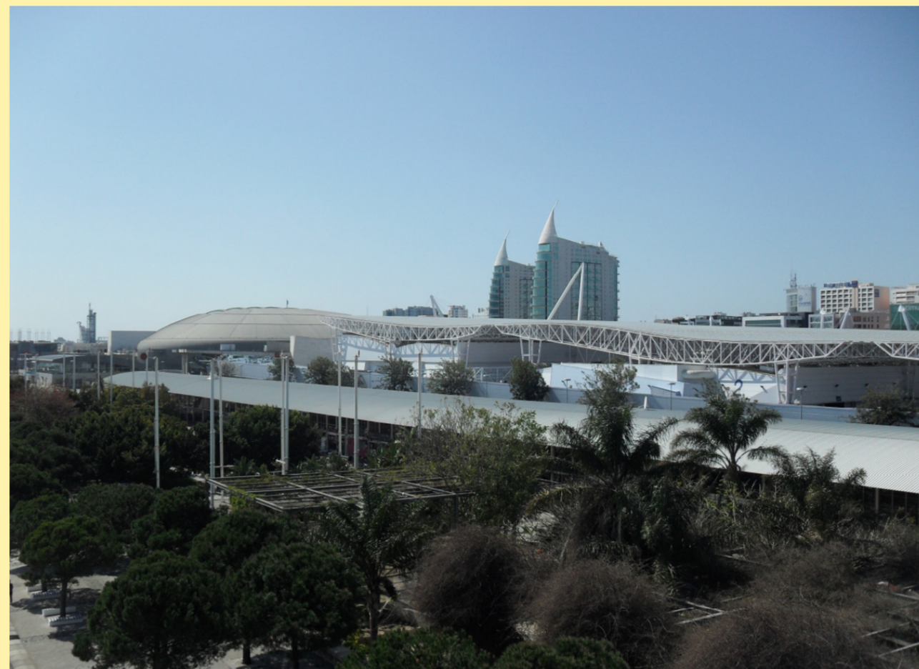
Moderne Architektur auf dem anlässlich der Expo 1998 erschlossenen Gelände, das heute verschiedene Funktionen erfüllen soll.
